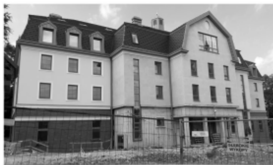
Stan budowy: Wrzesień 2021
